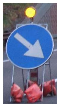
Figura 13: esempio di cavalletto correttamente predisposto per l'alloggiamento della lampada
